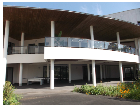
Bâtiment A « AUGEREAU »
